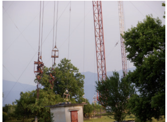
Verankerung der Stahlseile. Die Sendemasten stehen auf großen Betonkugeln und werden mit Stahlseilen verankert. Innerhalb der Masten sind Leitersprossen, die für Wartungsarbeiten dienen. Quelle: Valer Literat 2016
