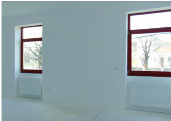
Renovierung der Räume in Schulgebäude B (Nr. 9)
