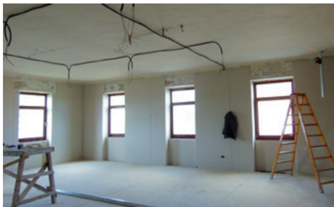
Renovierung der Räume in Schulgebäude C (Nr. 10). Fotos: Gerhard Klutsch, März 2021
