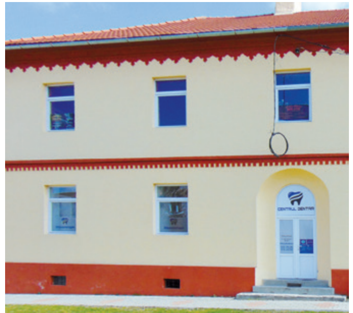
Dentalzentrum im Schulgebäude A (Nr. 8)
