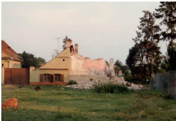
Die Ruine von Haus Nr. 15 nach dem Abriss 1987
