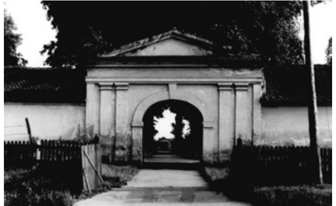
Gewölbtes Tor Friedhof - erbaut 1841
