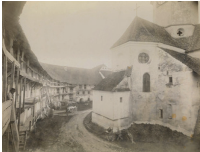
Innerhalb der Tartlauer Kirchenburg, Blick von Norden. Quelle: Staatsarchiv Kronstadt, ca. 1895
