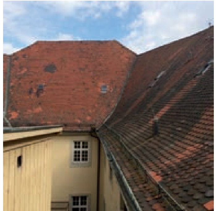
Ausgebessertes Dach mit verlegten Dachziegeln, neuen Schneefanggittern, gereinigten Kehlblechen und Dachrinnen
