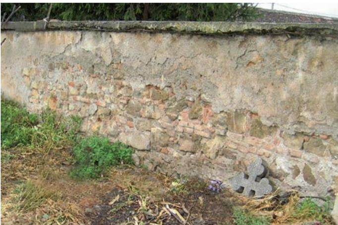
Bepflanzung roden, Drainage entlang der Außenwände legen (teilweise – dort, wo die Wand nass ist)
